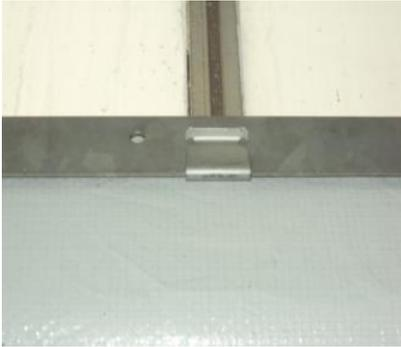
Экраны с помощью монтажных зажимов соединяются с профилем С тепличной конструкции.
