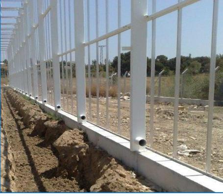
Дождевая вода, которая собирается с крыши теплицы, будет выводиться благодаря соединению желобов по краям теплицы со специально спроектированными передними колоннами. Система спроектирована т.о., чтобы в дальнейшем была возможность монтажа труб дренажной системы дождевых вод.
