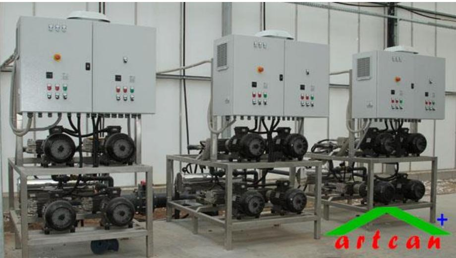
Для того, что система СИОД могла функционировать под высоким давлением, будут использованы плунжерные насосы высокого давления Annovi Neuberger XWL 50.15.
