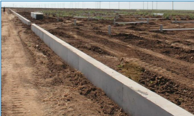
По периметру теплицы с использованием опалубки прокладывается бетонный брус шириной 28 см и высотой 50 см. Внутри бетонного бруса будет использовано 4 ряда железных прутьев Q10. Перед заливкой бетона из-под бетонного бруса извлекается сырой грунт, засыпается, а затем уплотняется мелкий стабилизирующий материал, после чего брус заполняется и опалубка соединяется. После соединения опалубки заливается бетон класса Б-25.
