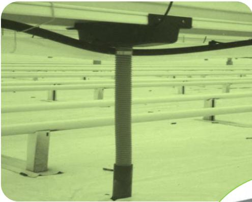
Для сбора поступающей дренажной воды и для отвода ее в дренажную систему на каждый лоток будет установлен желоб (крышка) для сбора. Эти желоба (крышки) будут прикреплены 12 мм саморезами.
