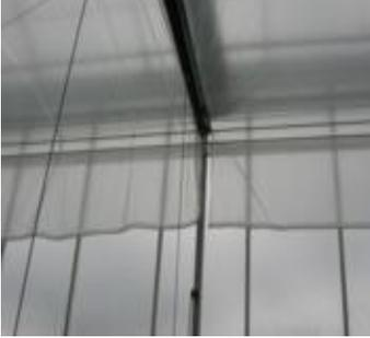
На концах секторов экранов для того, чтобы предотвратить скатывание экранов вниз, для того, чтобы облегчить движение экранов во время открытия и закрытия, будет использоваться стальной трос. Для того, чтобы данный трос не повреждал экраны, на нем будут установлены пластиковые зажимы. Экраны будут свисать с окончаний секторов на 50 см, а также могут быть
