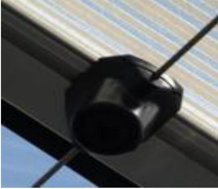
Механизм зашторивания является тросовым механизмом, при котором используется стальной трос 7 x 7 Ф 3 мм.
