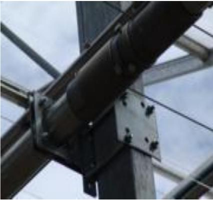
Для вал механизма будет использована гальванизированная труба, качества А, диаметром 60,3 мм и толщиной стенки 3,65 мм.
